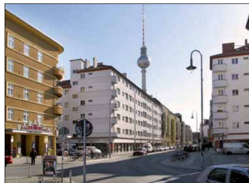
oben: Einzeldenkmal in der Kollwitzstraße, denkmalgerechte Sanierung
