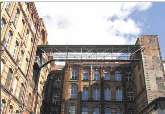
Ehemalige Opernwerkstatt in der Zehdenicker Straße, Mitte. Das Objekt wurde 2008 im Bieterverfahren verkauft. Hier entstehen Ausstellungsflächen, Büros und Wohnungen.
