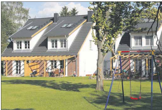
Unmittelbar am Wasser gelegen: Das Projekt »Alter Fährhof« in Berlin-Heiligensee
