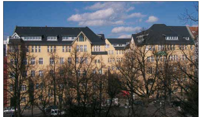
Schillerstraße 12-15, Berlin-Charlottenburg, (nach dem Dachgeschossausbau)
