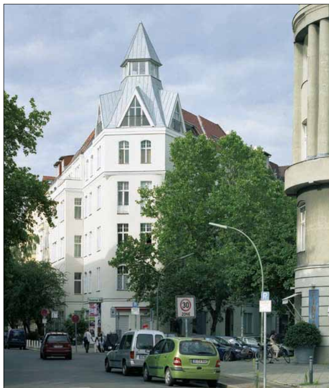
Motzstraße 64 Ecke Ansbacher Straße 75, Berlin-Schöneberg
