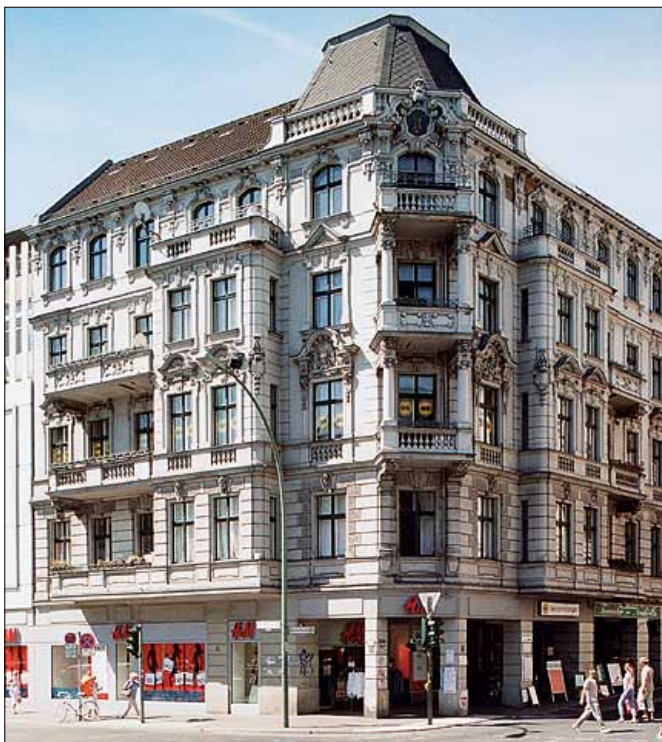
Wohn- und Geschäftshaus, Karl-Marx-Straße 108 in Berlin-Neukölln
