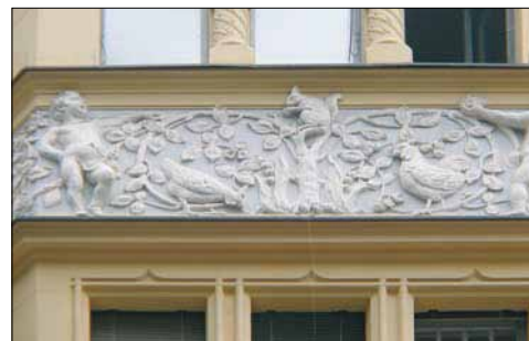
Fassadendetail eines repräsentativen Wohn- und Geschäftshauses:
